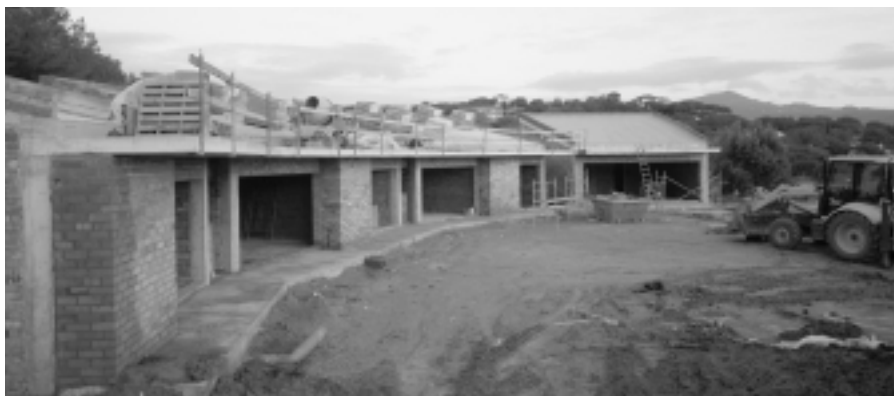
Les obres de l'Escola Bressol ja estan força avançades.
