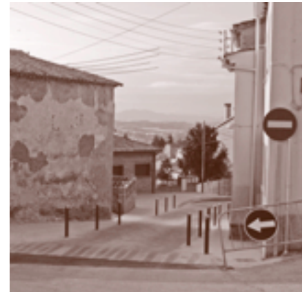
Arranjament del pas de ca l'Espardenyer.
